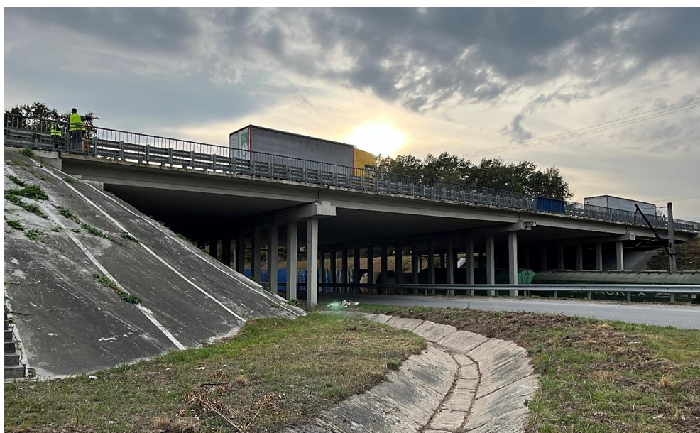
Рисунок 1 — Вид на фасад шляхопроводу, виконаного із збірних плит за типовим проектом ВТІІ-21
