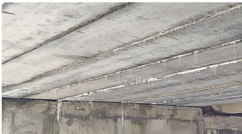
Рисунок 11 — Інтенсивне вилугування плит у вигляді сталактитів
