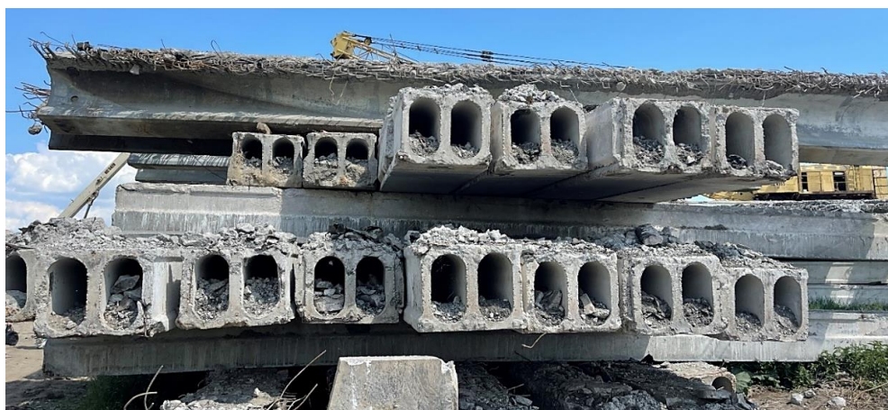
Рисунок 3 — Загальний вид на переріз плит ВТІІ-21
